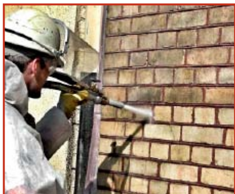
Klinkerreinigung im Feuchtstrahlverfahren
