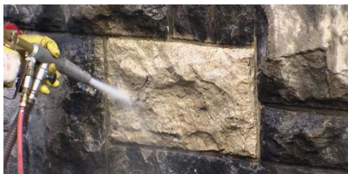
Top-Gun Injektorstrahlpistole (trocken und/oder feucht)
