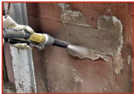
z.B.: Betonsanierung, Entfernung alter Anstriche, Entrosten der Bewehrungsstäbe
