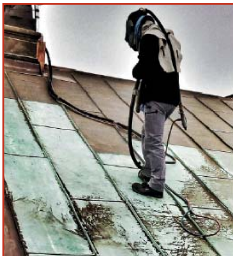
z.B.: Grünspanentfernung auf einem Kupferdach
