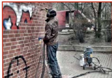
z.B.: Graffiti-Entfernung von Klinker (hier: trocken)
