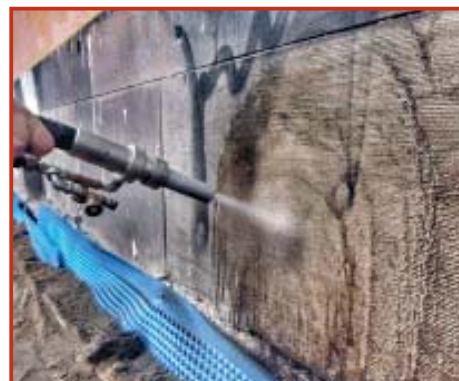
z.B. weicher Sandstein im Feuchtstrahlverfahren inkl. Graffiti-Entfernung ohne Schädigung der Scharrierung
